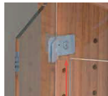
Montaż szkło-drewno bez użycia płytki frontowej
